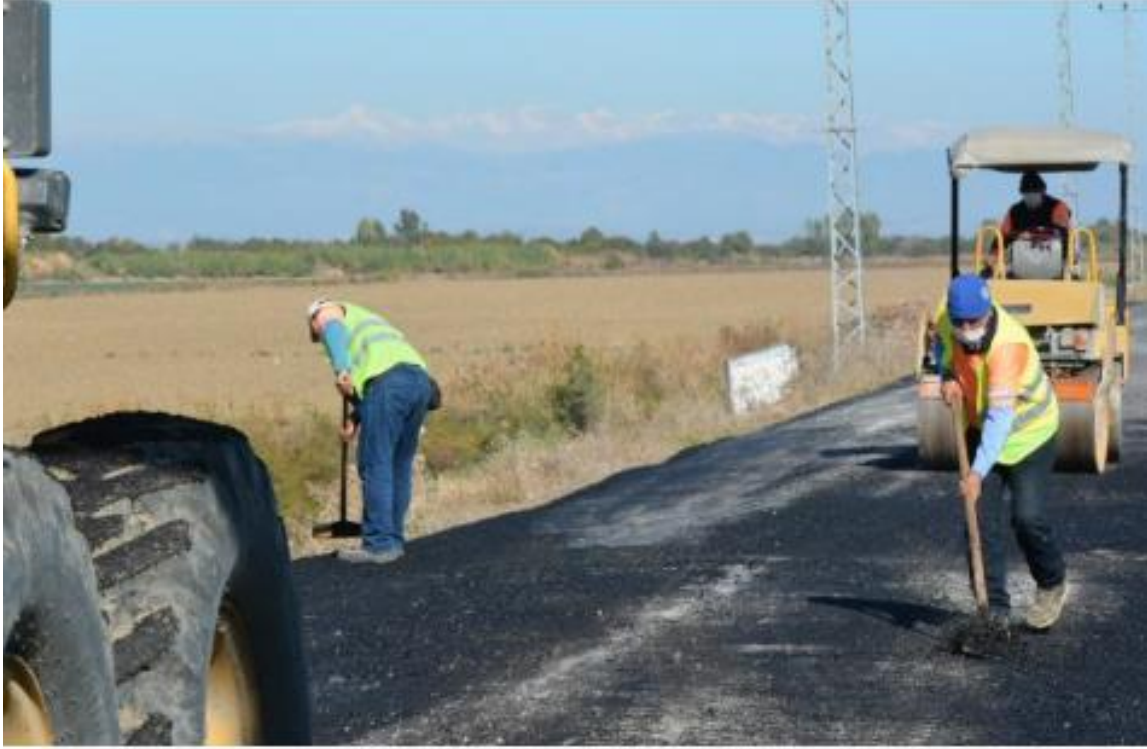
4 MAHALLEYİ BAĞLAYAN GRUP YOLUNDA 25 YILDIR İLK KEZ KAPSAMLI BAKIM
